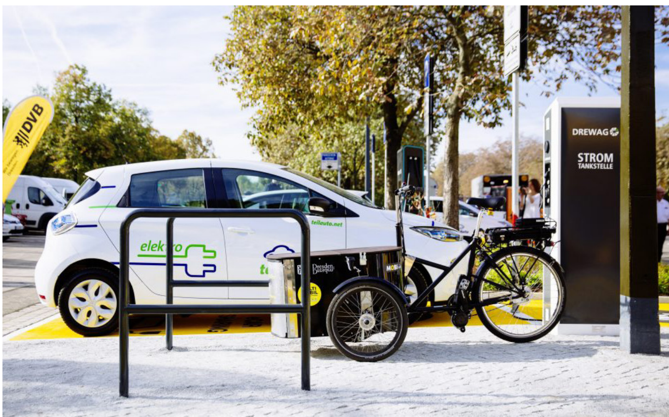
Посејојка за полнење на електрично возило во Дрезден, СР Германија (извор: www.buildup.eu )
